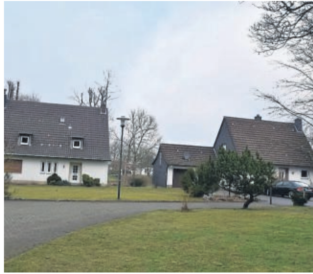
Reif für den Abrissbagger: das Pfarrhaus (links) und das Küsterhaus. Dort soll der neue Kindergarten entstehen.
