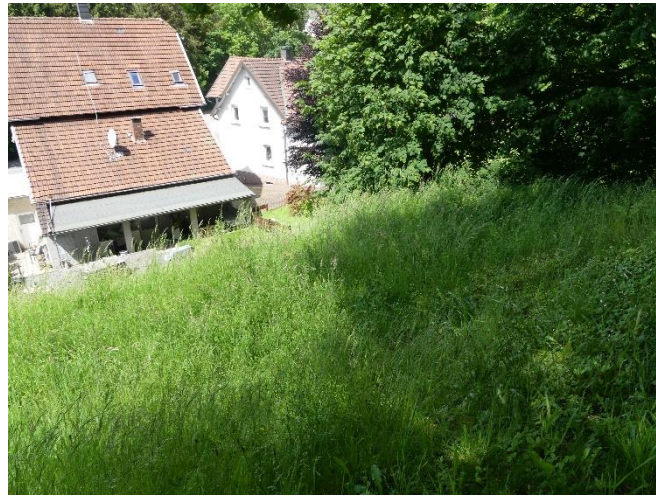
Abbildung 14: Dieser Abhang auf dem Evingser Friedhof muss saniert werden. (Foto: Volker Knipp)
