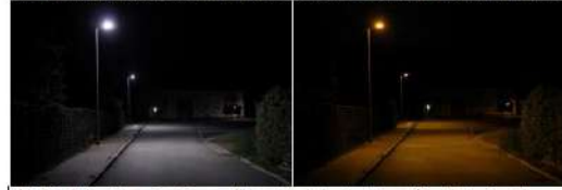
Abb. 5-6: Beleuchtungssituation vor (li.) und nach der Umrüstung (identische Einstellungen).
