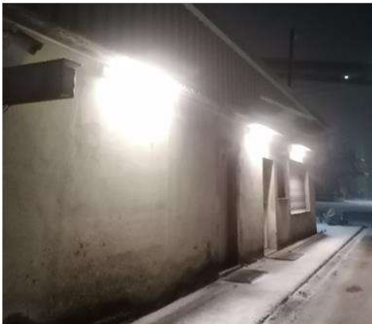
Abbildung 4: Zustand der Beleuchtung bisher am
